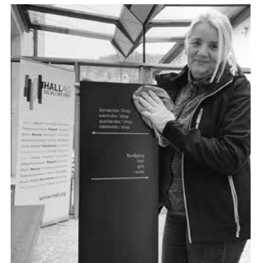
Dragica Pesa bei Reinigungs- und Sanierungsarbeiten.
